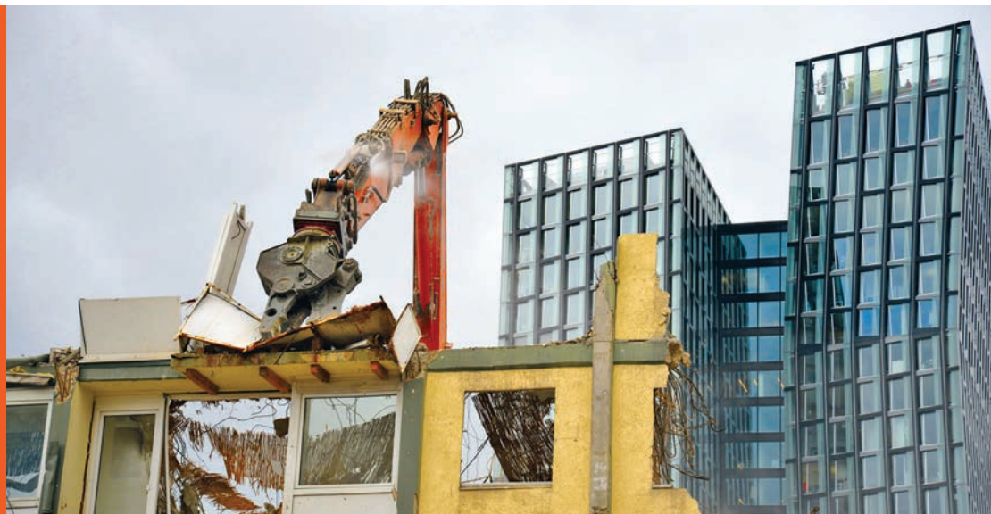
Abriss der Esso-Häuser auf St. Pauli, im Hintergrund die tanzenden Türme
