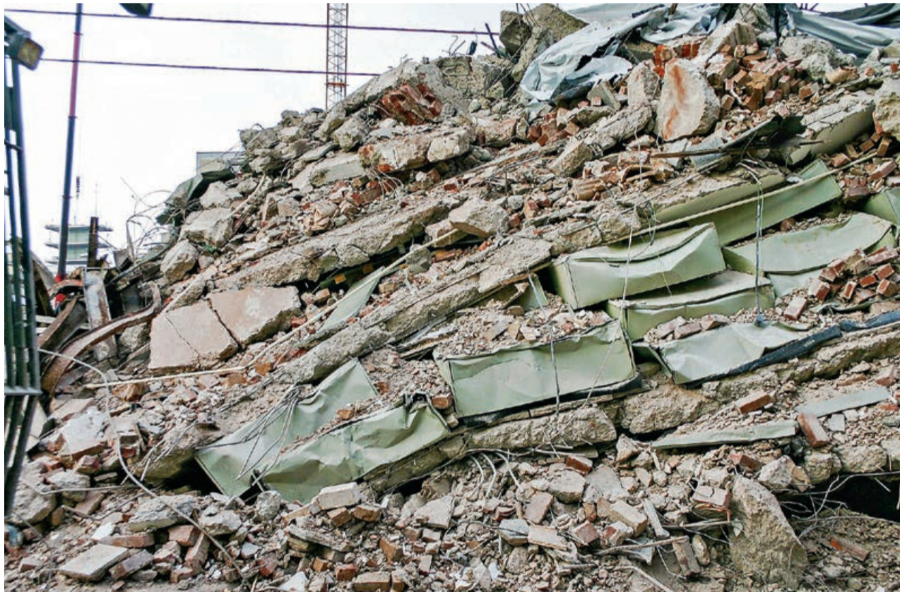
Archivgut im Schutt nach Einsturz des Historischen Archivs der Stadt Köln am 3. März 2009
